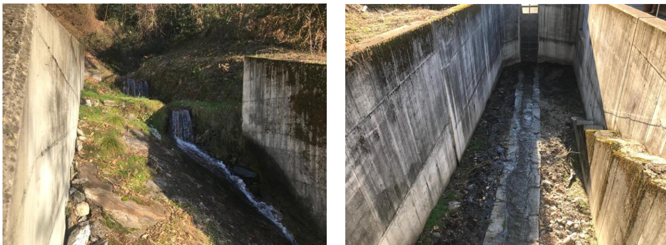
Fig. 3 A sinistra, tratto del riale Riganella che passa da naturale a poco naturale. A destra, camera di contenimento prima di venire intubato e passare quindi sotto al sedime della ferrovia. Foto scattate il 17 febbraio 2021.
