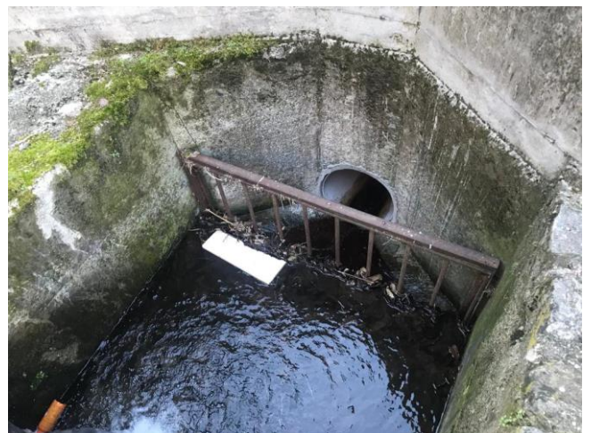
Fig.2 A sinistra tratto del riale Noco in stato poco naturale. A destra inizio del tratto intubato del riale Noco per l'attraversamento del sedime ferroviario. Foto scattate il 17 febbraio 2021.
