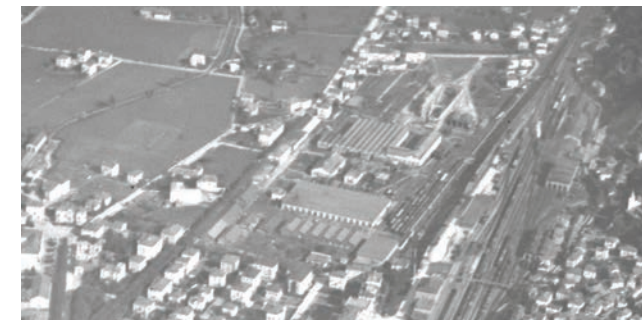
Foto aerea da sud con la "Cattedrale" in costruzione (1919)
